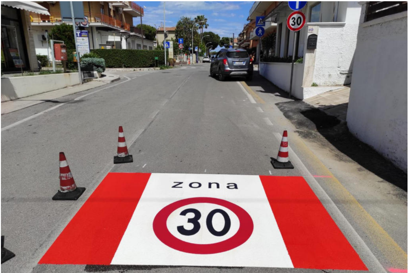
Esempio di varco Zona 30 in segnaletica verticale, con parte centrale in preformato e bande laterali rosse in resina antiskid a rullo, realizzate in opera per adattare il varco all'intera larghezza della corsia - Tortoreto (TE)
